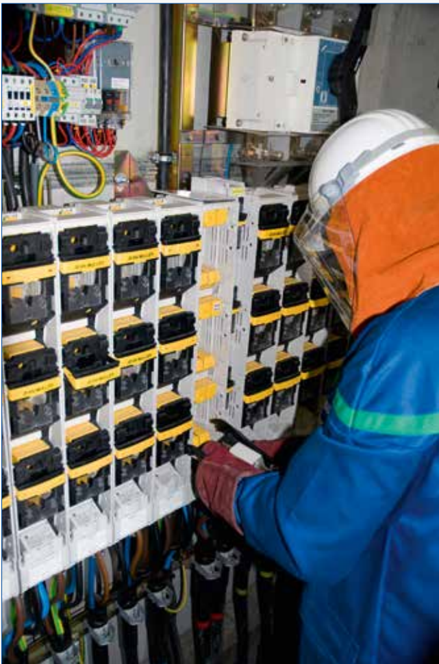
De 230/400 V-lijnen zijn hier beveiligd door zekeringen met klapdeksel.
