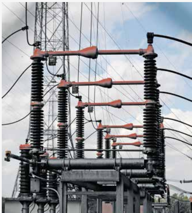
Roterende scheiders op een 150 kV-railstel.
