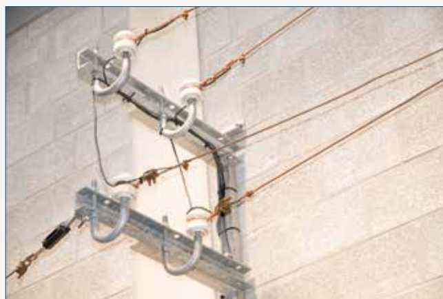
Gevelnet met overgang naar grondnet.
