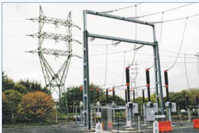
Aftakmasten op een 150 kV-lijn van Elia
