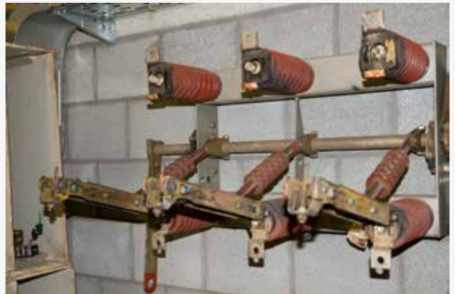
Beschadigde vermogensschakelaar ten gevolge van een overslag: de klemmen voor de schakelmessen zijn volledig weggebrand.
