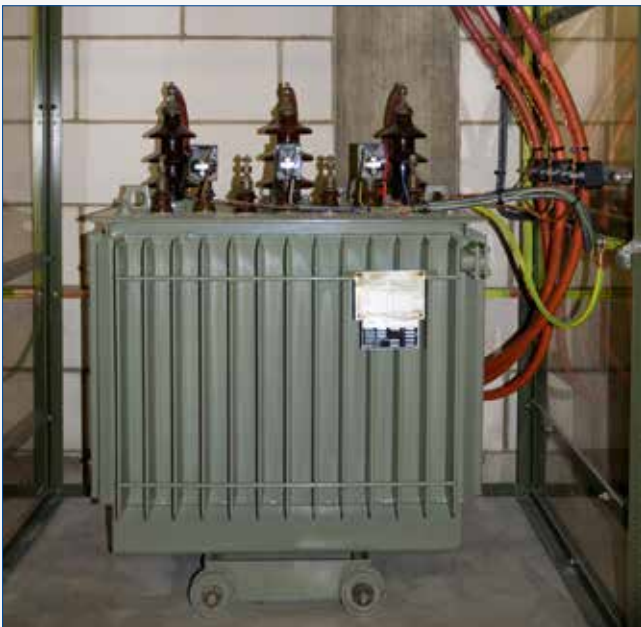
Compacte giethartransformator in een distributietransformatorpost van Eandis
