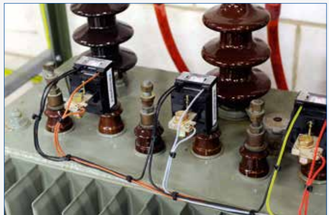
Spanningstransformatoren op een hoogspanningstransformator.
