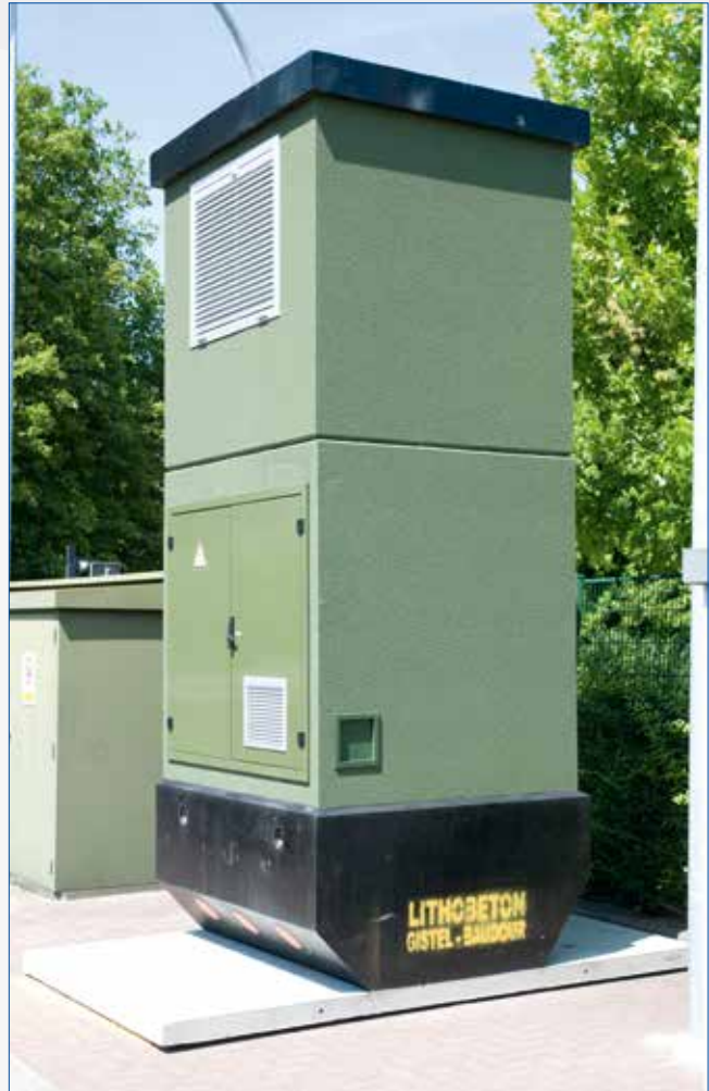
Modern en compact torentransformatorstation. De torenconstructie vormt samen met de betonplaat één geheel. De betonplaat en het zwarte gedeelte komen onder het maaiveld. De drie oranje markeringen onderaan zijn doorgangen voor ondergrondse kabels.
