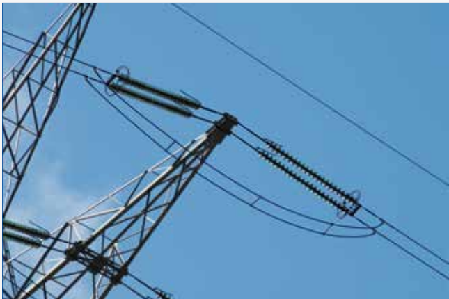
Isolatoren van een 380 kV-lijn.
