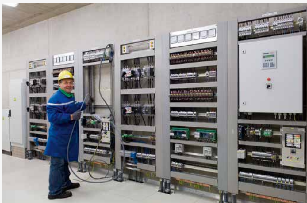
Rek met meettoestellen en communicatieapparatuur in een distributie-schakelpost van Eandis.
