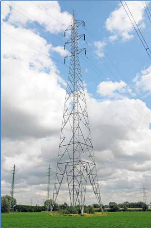
Lijn 150 kV Gerealiseerde overspanning: ongeveer 350 m Volledige hoogte: 50 m
