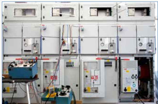
Opstelling van modulaire luchtgeïsoleerde schakelapparatuur tijdens een controle.
