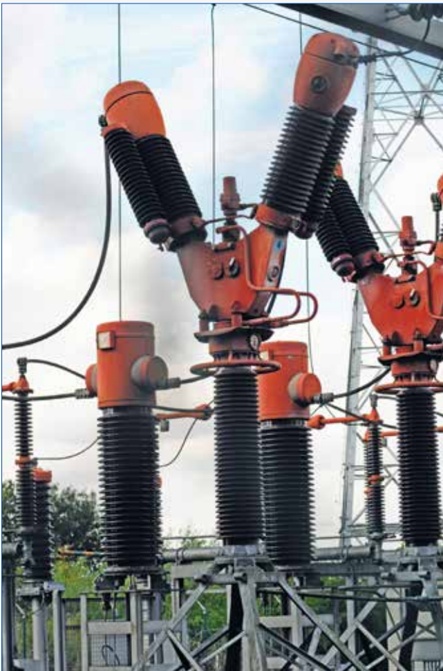
Vermogenschakelaars op een 150 kV-railstel. Totale hoogte is ongeveer 5 m.
