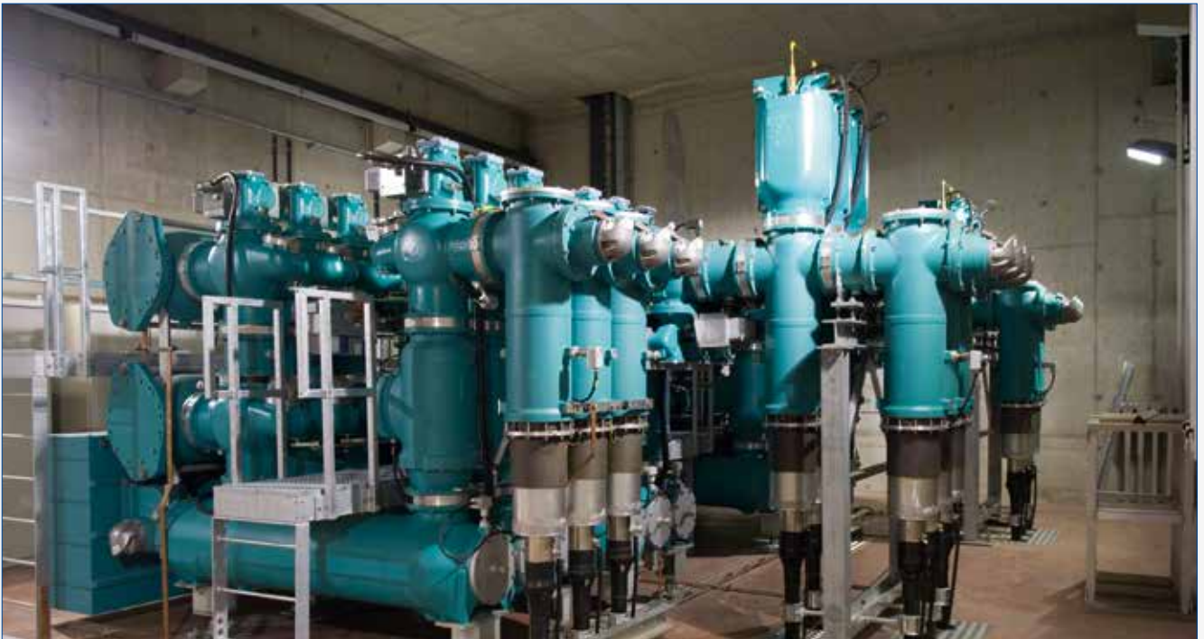
SF 6 geïsoleerde schakelapparatuur van een 150 kV onderstation van Elia.
