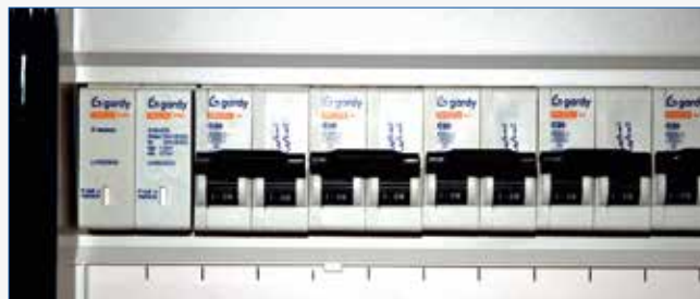
De twee eerste modules van de rij zijn de globale overspanningbeveiliging voor een monofasige aftakking.
