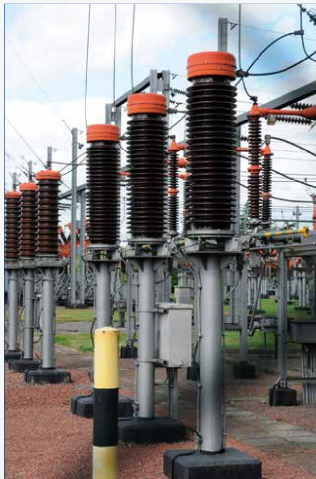
VDR overspanningsafleiders in een 150 kV openluchtstation.
