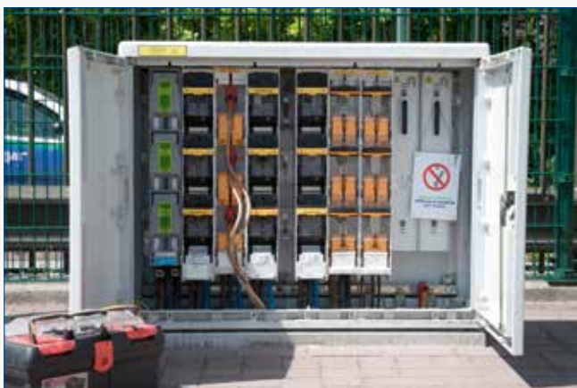
Bovengrondse voetpadkast met 9 vertrekken (waarvan 7 aangesloten en 2 voor uitbreiding) en een aardingset. Beveiligd door zekeringen met klapdeksel.
