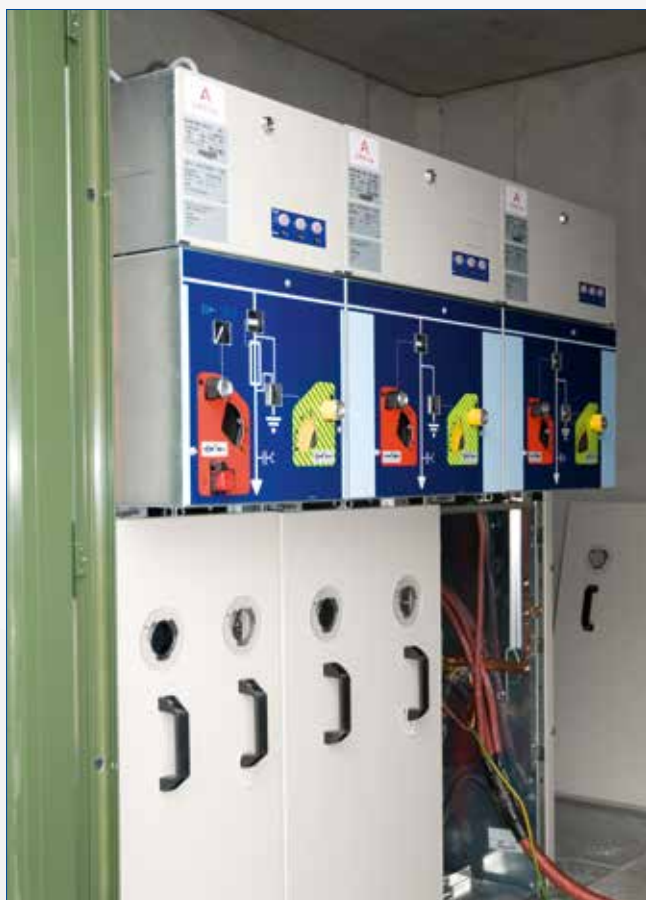
Binnenkant linker wand van een geprefabriceerde distributietransformatorpost: middenspanningsgedeelte.
