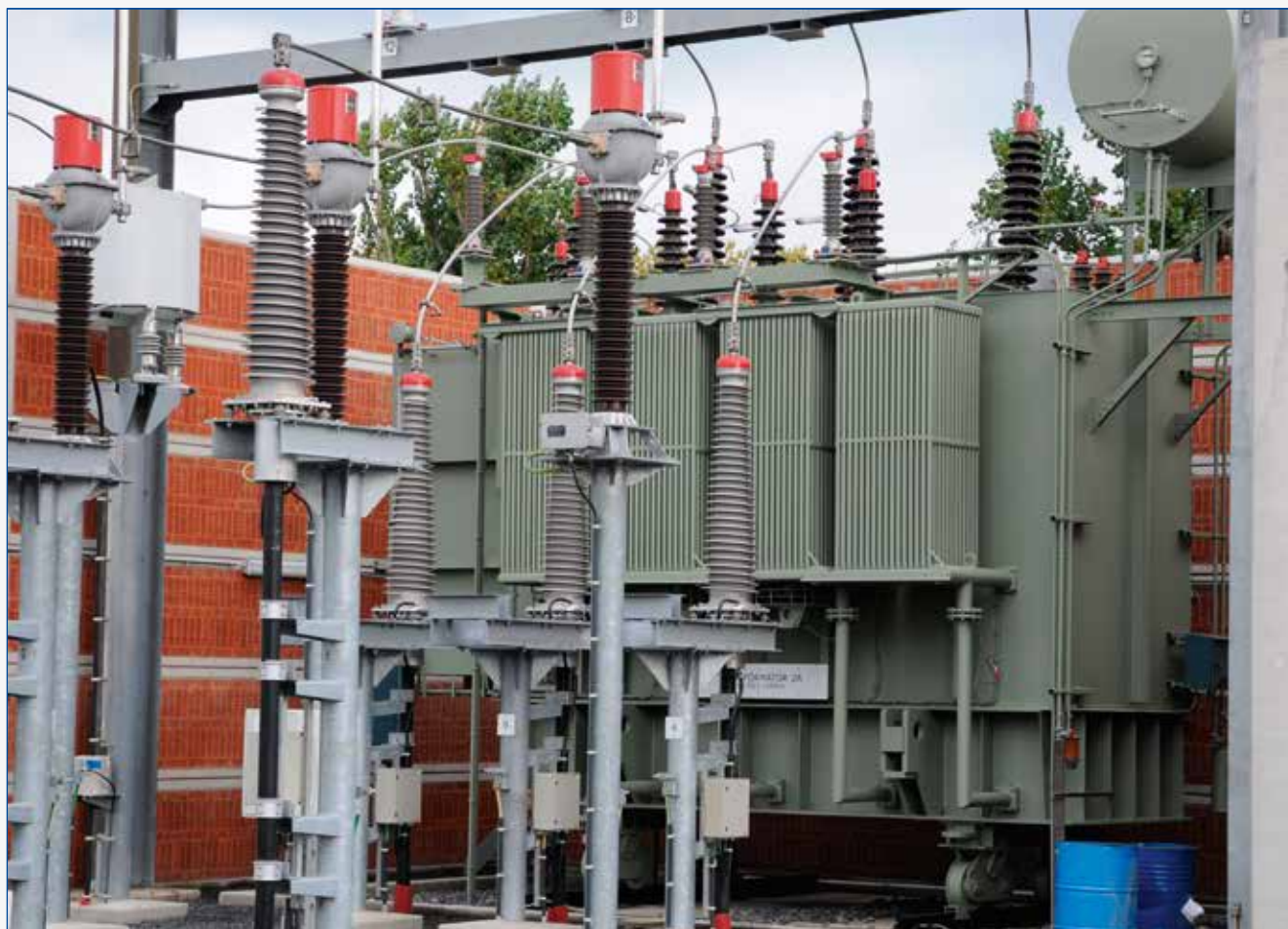
150 naar 70 kV transformator van Elia Koeling: olieradiatoren met ventilatoren. Vermogen: 125 MVA
