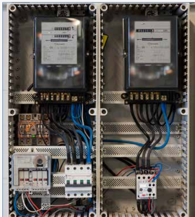
Beide kWh-meters worden gevoed door dezelfde aftakkabel en aansluitautomaat.
