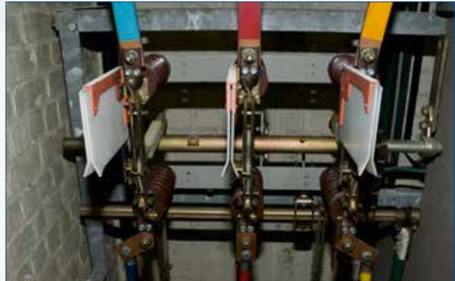
Aankomst van een ondergrondse kabel op middenspanning in cel 1 van een (oude) klantpost.
