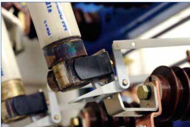
Mechanisme voor ontgrendeling van de lastschakelaar.
