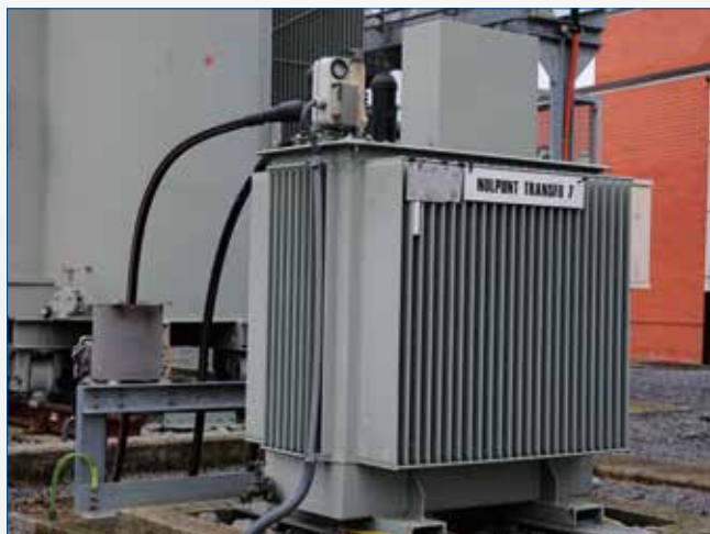
Nulpunttransformator op een 10 kV vertrek.
