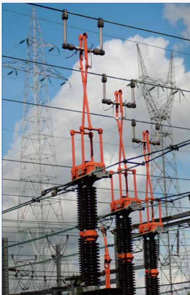
Pantograafscheiders op een 150 kV-railstel. Hoogte is ongeveer 4 m.
