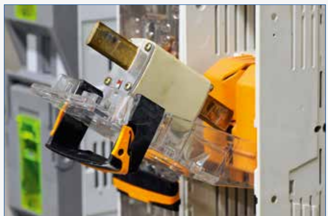
Uitgeschakelde mesveiligheid op vertrekkende distributielijnen 230/400 V in een distributiepост.
