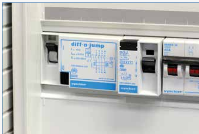
Driefasige differentieelschakelaar 300 mA en monofasige differentieelschakelaar 30 mA in voedingsbord.
