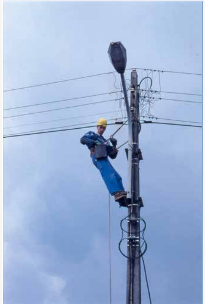
Uitvoering van een aftakking op een bundelnet.
