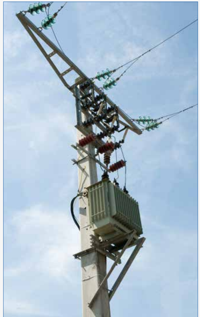
Paaltransformatorstation met hoogspanningszekeringen en scheidingschakelaar.
