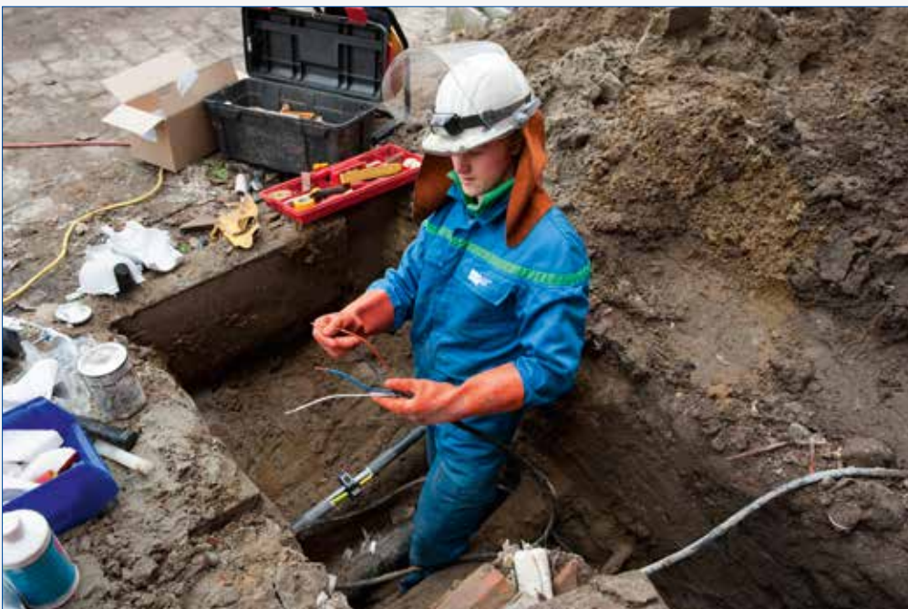
Uitvoering van een aftakking op het grondnet.
