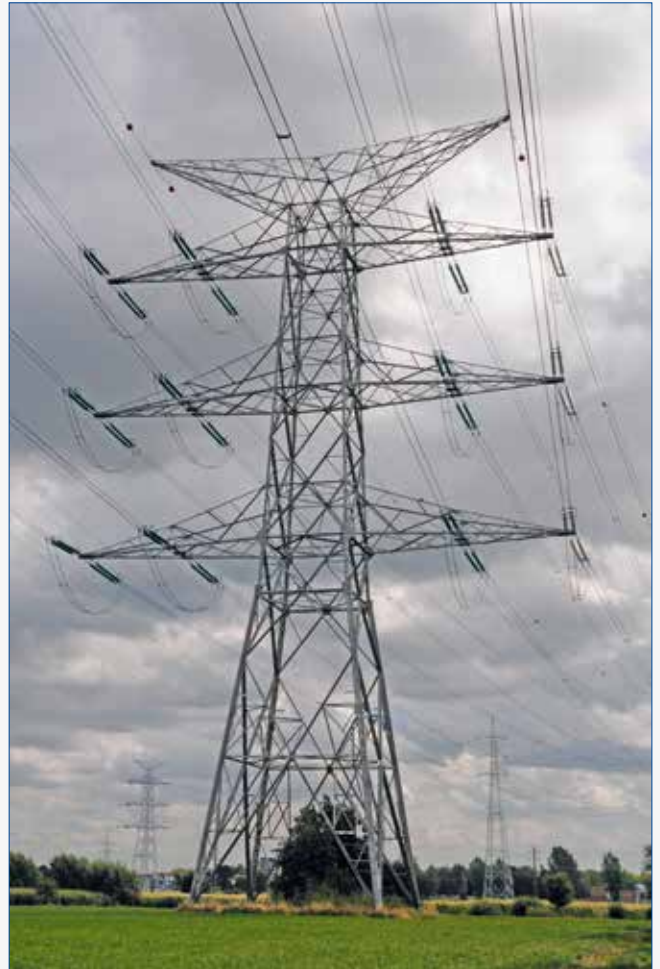
Lijn 380 kV Gerealiseerde overspanning: ongeveer 400 m. Volledige hoogte: 65 m
