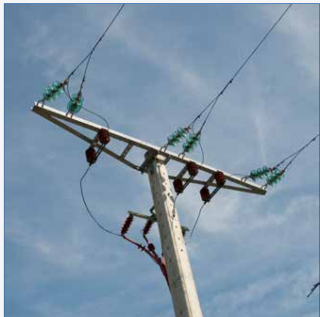
Aansluiting van een ondergrondse XLPE op een bovengrondse 15 kV-lijn.
