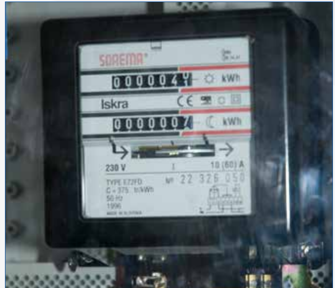
kWh-meter voor tweevoudig uurtarief Het bovenste telwerk registreert het dagverbruik. Het onderste telwerk registreert het nachtverbruik.
