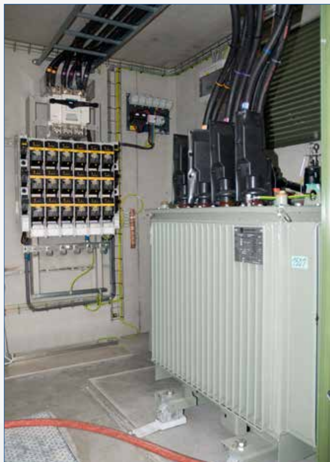
Binnenkant rechter wand van een geprefabriceerde distributietransformatorpost: transformator met achteraan de zekeringen voor de 230/400 V-vertrekken.
