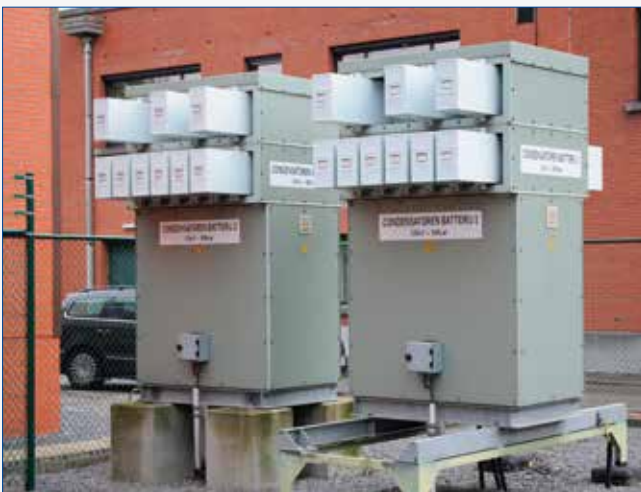
Condensatorbatterij op een uitgaande 10 kV-lijn van Elia.
